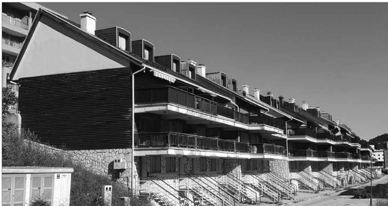
Slika 13: Prvi nastanitveni objekti pod vrhom Bjelašnice, Izet Arslanagić, 2005 (foto: Alma Hudović Kljuno)
